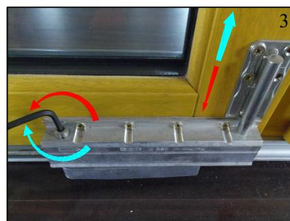
Réglage de la hauteur de l'ouvrant, à gauche et à droite avec une clé à embout Torx.
