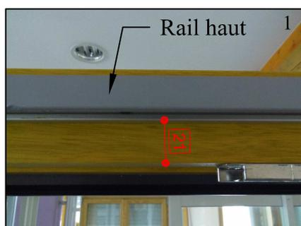
Dessous du rail haut doit être à 21 mm du fond de feuillure du dormant.
